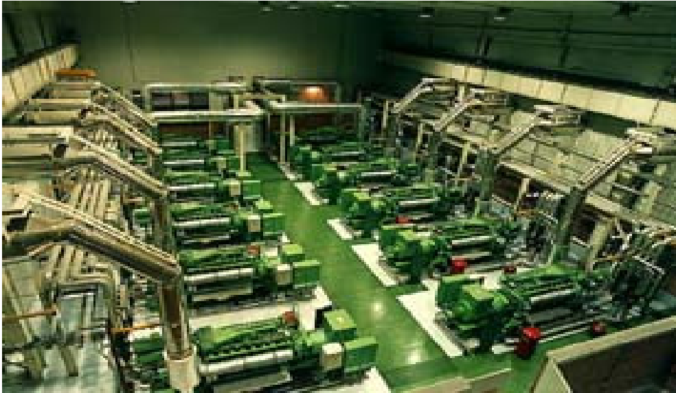
Casa de máquinas
