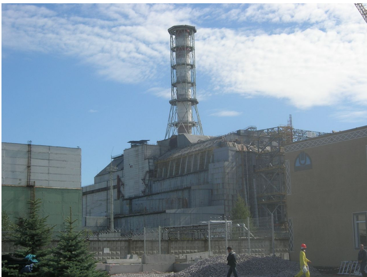
O "sarcófago" que abriga o reator 4, construído para conter a radiação liberada pelo acidente.
